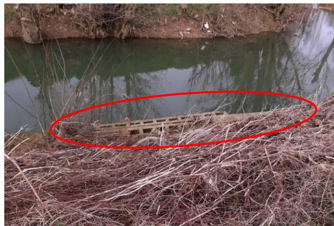
Confortement de berge avec poteaux en béton
